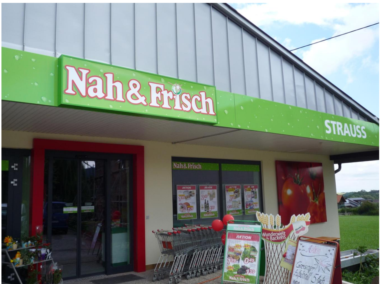
Die Arbeiten haben sich gelohnt! Der Nah&Frisch-Markt Strauß erstrahlt in neuem Look.
